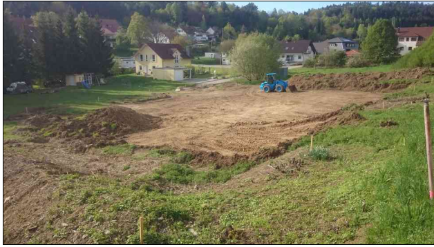
Abbildung 6: Lagerfläche für Erdmaterial
